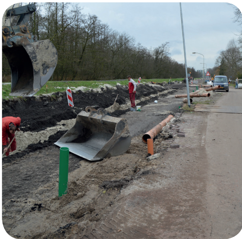
De weg wordt opgebroken
